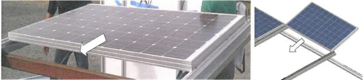
**Etape 2 :** insérer les Clips TU + MALT (ACI383) à chaque jonction de module dans la colonne
