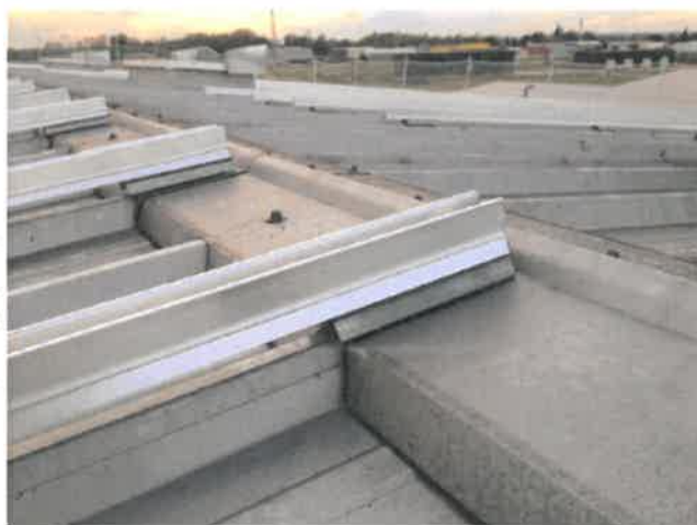
Positionnement des rehausses de faîtage : une seule par colonne de rails
