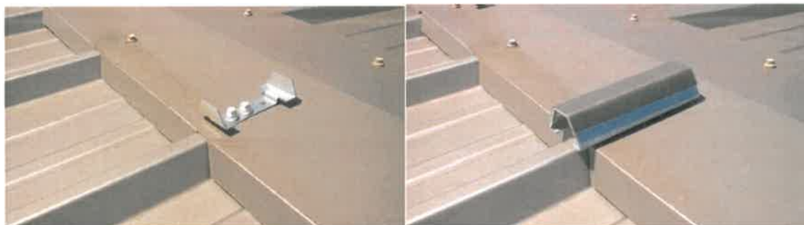
Positionnement des rehausses de faîtage : une seule par colonne de rails
