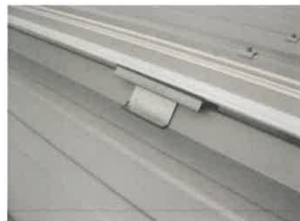
Cas de fixation avec 2 vis VBS et 2 vis VOS
