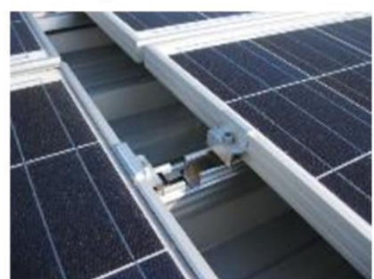
Au joint de dilatation
