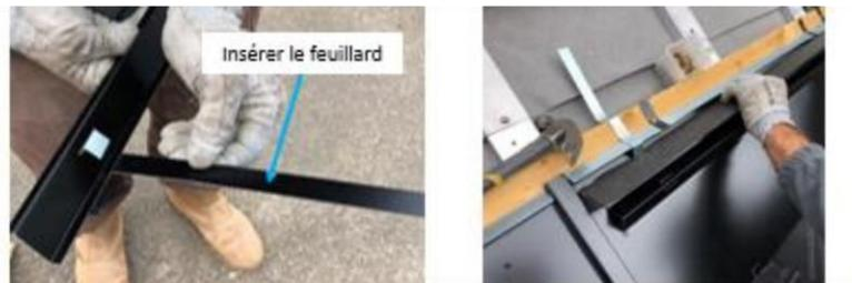
**Figure 25 – Pose des appuis de tuiles (kit TS-2)**
