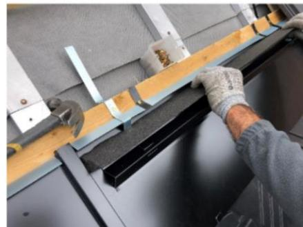
**Figure 38 – Mise en place des éléments de couverture (kit TN-1)**
